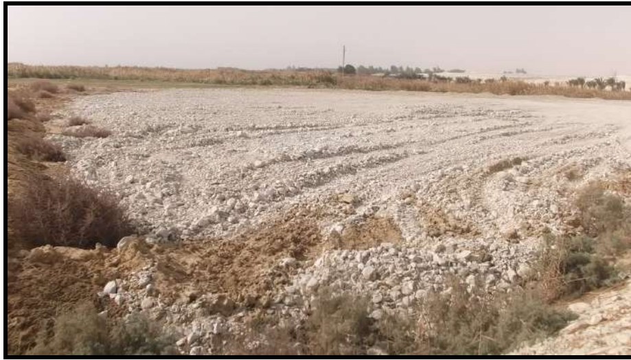
صورة (٣٣) ردم التربة بالطفلة لرفع منسوبها بمجهود خاص من الأهالي باللواء صبيح عام ٢٠١٥ م المصدر: الدراسة الميدانية يوم الجمعة الموافق ٦/١٢/٢٠١٥م، وتقع إحداثيات الصورة عند منسوب ٦٦,٩ متر ودائرة عرض ٢٢ ° ٠٤ ° شمالاً وخط طول ٤٢ ° ٥٥ ° شرقاً واتجاه الصورة ناحية الشمال الغربى
