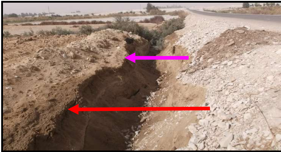
صورة (٢٣) تهدم جوانب المصارف الأهلية بجوار بركة اللواء صبيح بالفرافرة عام ٢٠١٥ م المصدر: الدراسة الميدانية يوم الأحد الموافق ٢٠١٥/١٢/٦ م، وتقع إحداثيات الصورة عند منسوب ٦٦,٩ متر ودائرة عرض ٢٢ ° ٠٤ ' ٢٧ شمالاً وخط طول ٤٢ ° ٥٥ ' ٢٧ شرقاً واتجاه الصورة ناحية الشمال الغربي
