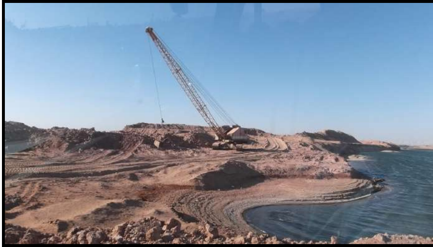
صورة (٣٠) تعميق بركة موط بالداخلة لزيادة قدرتها على تخزين مياه الصرف عام ٢٠١٥ م المصدر: الدراسة الميدانية يوم الجمعة الموافق ٢٠١٥/١٢/٤م واتجاه الناظر ناحية الشمال الشرقي
